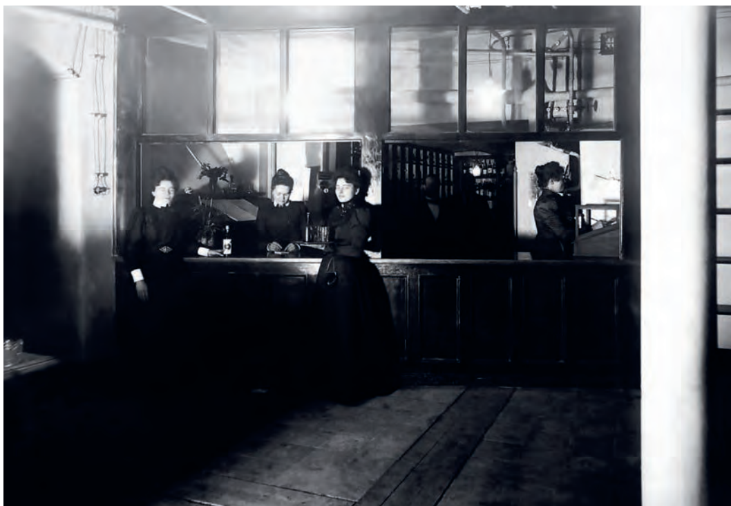
Serveringspersonal vid dryckesdisken i Tattersalls källare.
