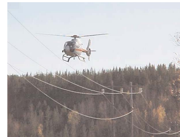
Foto: Skellefteå Kraft Elnät
