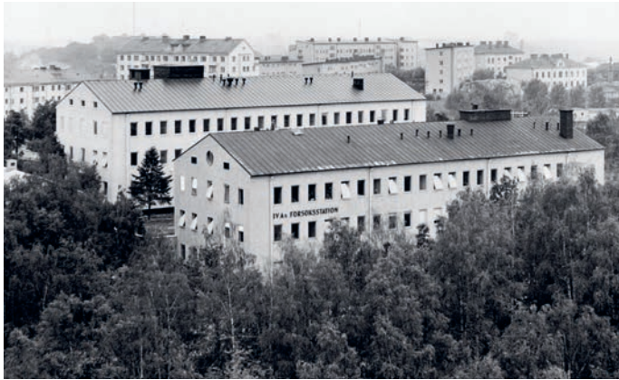
IVA:s forskningsstation byggdes med statligt stöd och genom att mark uppläts vid Drottning Kristinas väg vid KTH. De två byggnaderna kallades för "forskarhotell" i pressen och området döptes till "den nya vetenskapsstaden". Här fanns också branchforskningsinstitut och provningsanstalt.
