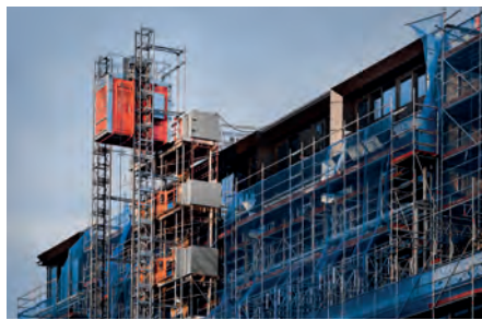
Så här kan Alimaks bygghissar se ut i dag. Här på en arbetsplats i Stockholm.
