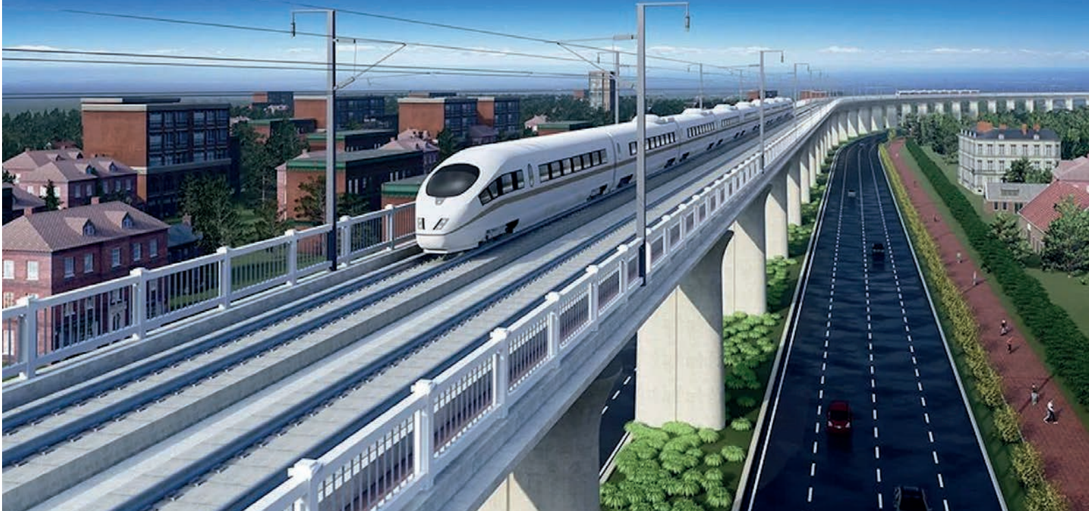
Skanska har presenterat ett förslag för att bygga banor för höghastighetståg på upphöjda pyloner av betong. Byggjätten räknar med en betong-åtgång på 15,3 miljoner kubikmeter för projektet. Det motsvarar nästan två och en halv gånger Sveriges samlade produktion förra året.
