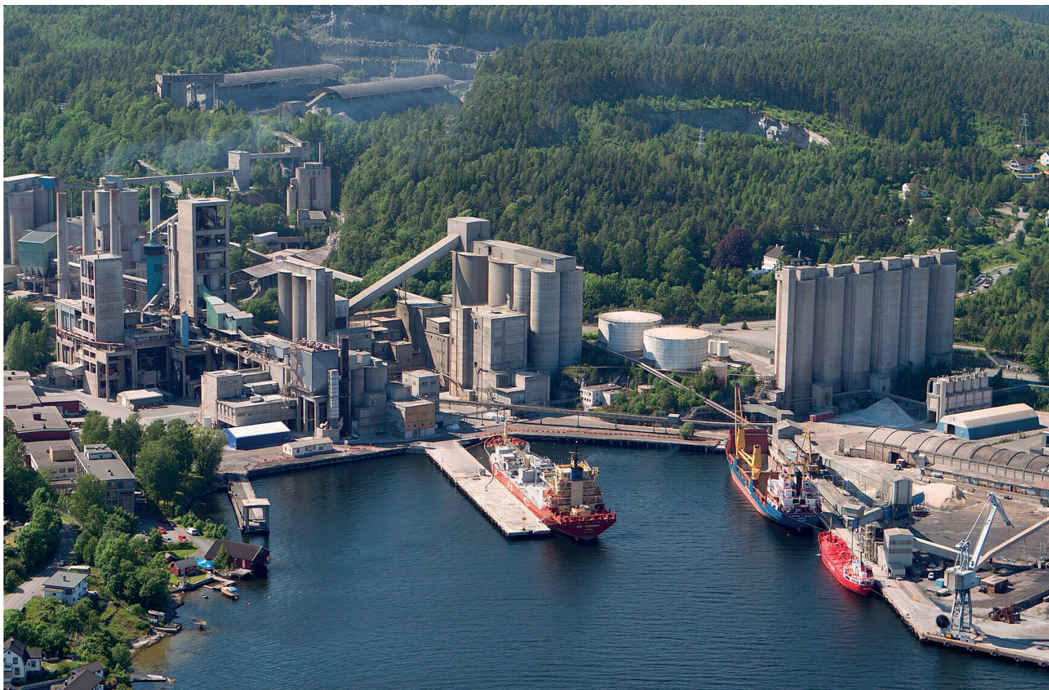
Cementas systerbolag Norcem bygger just nu en anläggning i Norge som ska stå klar 2024. Den ska använda så kallad amineteknik, där vattenlösningar av olika alkylaminer används för att avlägsna koldioxid från rökgaser.
