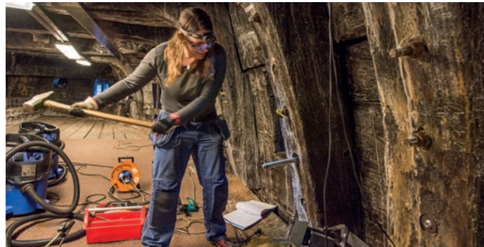
Tack vare bultarna från Sandvik har Vasa blivit mer stabilt och 5 ton lättare.
