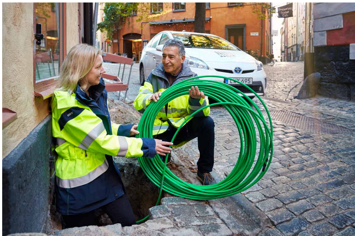
Figur 29: Vid utbyggnad av fibernät i befintliga stadsdelar behöver kabelgrävningar minimeras.
