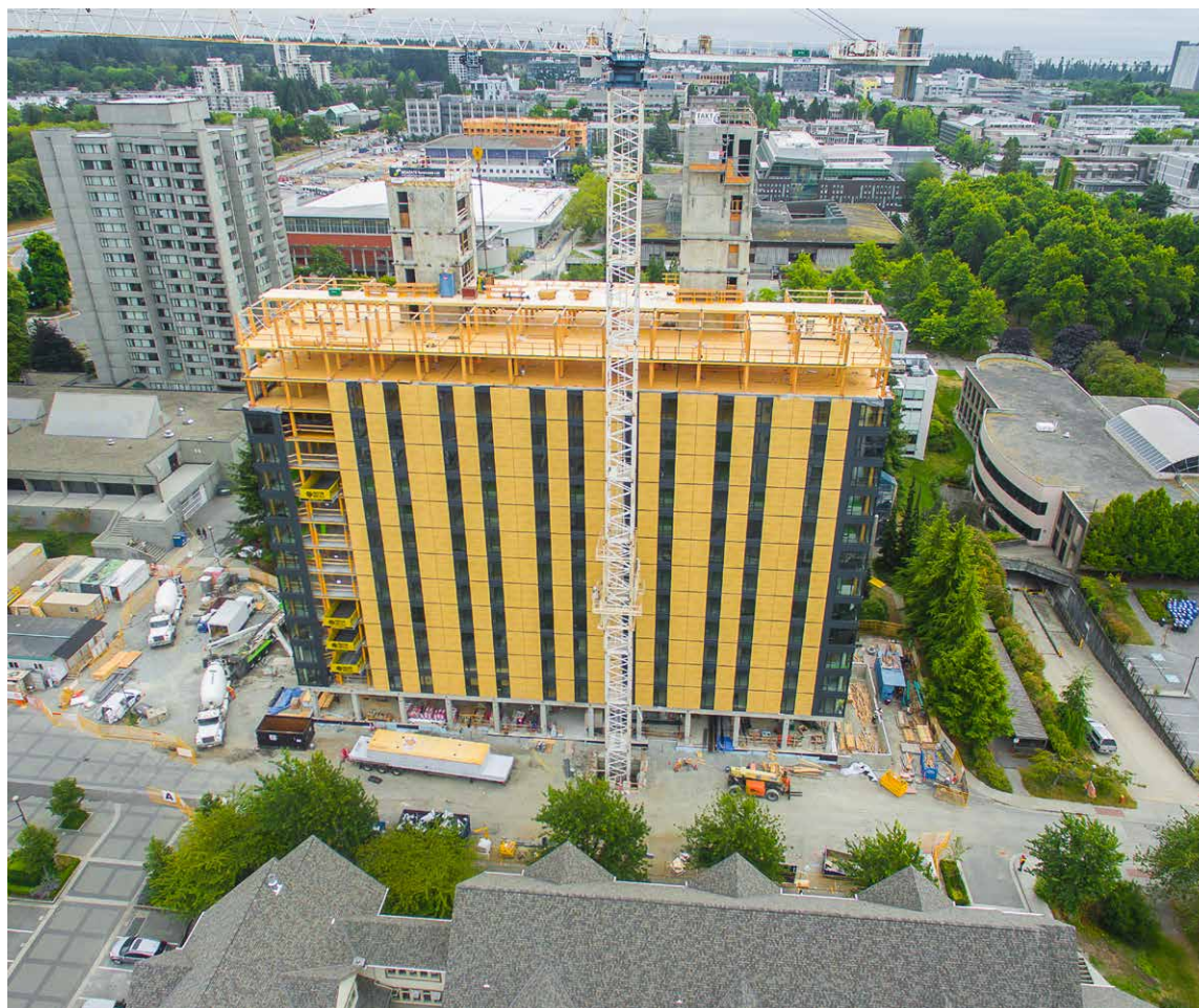
Figur 8: University of British Columbias studentbostäder är världens högsta träbyggnad. 53 meter hög med 18 våningar. Byggnaden har hisschakt av armerad betong.
